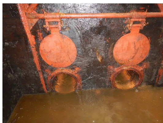
dvojice základových výpustí DN 400 s brýlovým deskovým uzávěrem nátoky
