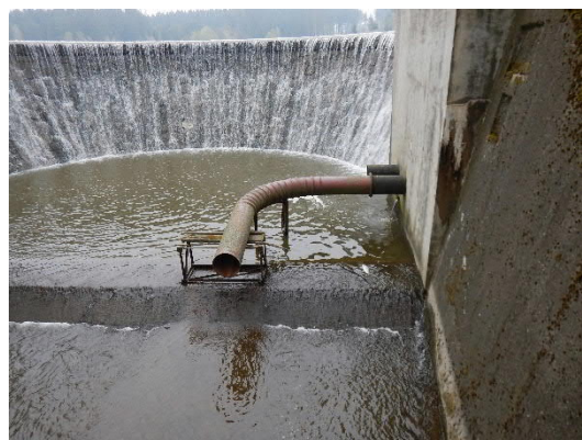
prodloužení levé SV zatažená za práh vývaru
