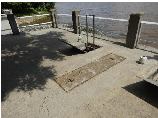
vstup do komory uzávěrů spodní výpusti
