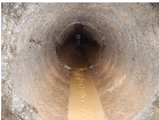
přívodní potrubí DN 600
